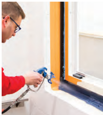
16 Z interiéru utěsněte Soudatight LQ / SP
