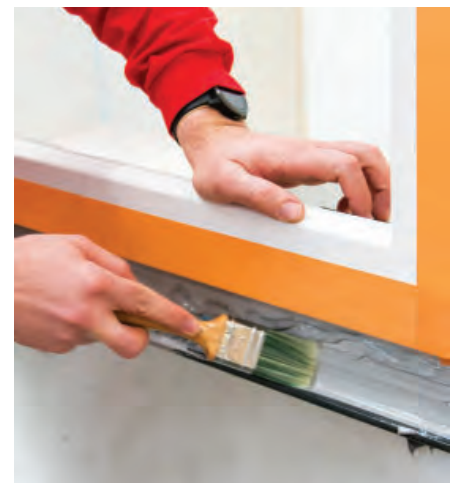
17 Pro utěsnění z exteriéru použijte Soudatight Hybrid
