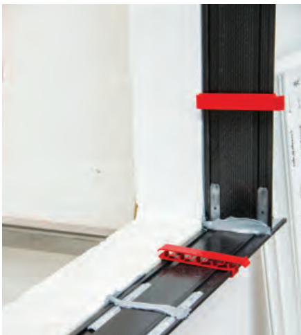
12 Utěsněte vnitřní rohy rámu a umístěte pružné klíny
