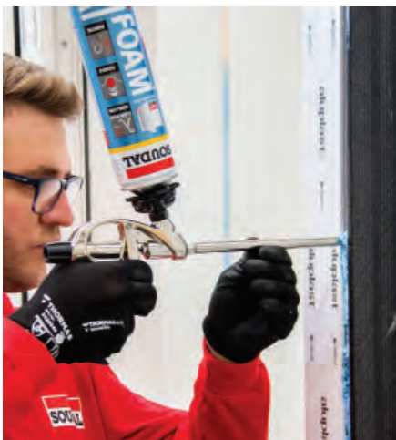
15 Odstraňte pružné klíny a vyplňte přípojovací spáru FLEXIFOAM
