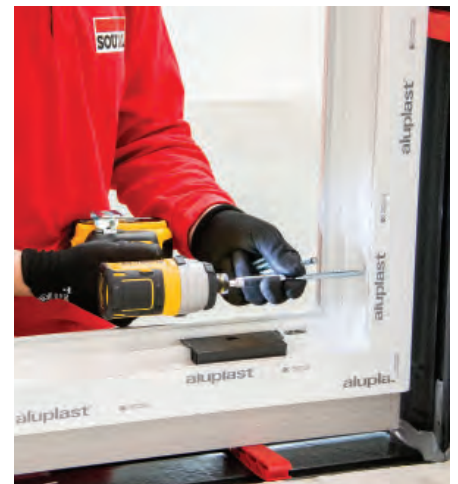
14 Rám okna mechanicky upevněte
