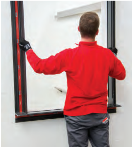
09 Umístěte rám na ostění a přitlačte s mírným pohybem nahoru, dolů a do stran
